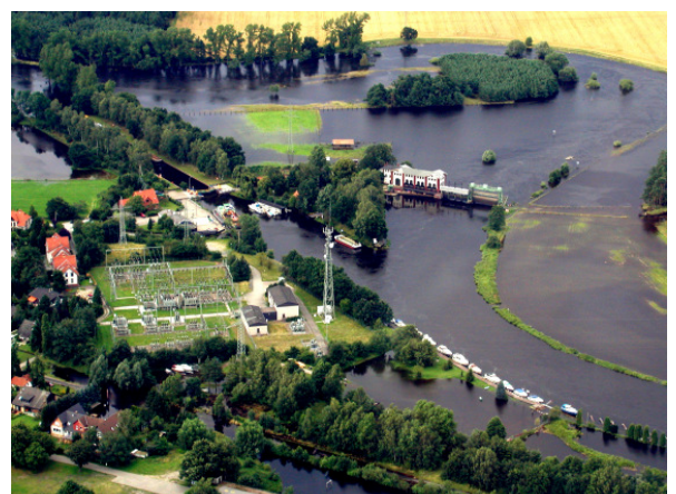
Abb. 2: Schleuseninsel Oldau während des Hochwasserereignisses am 24.07.2002 (WSA Verden, 2002)
