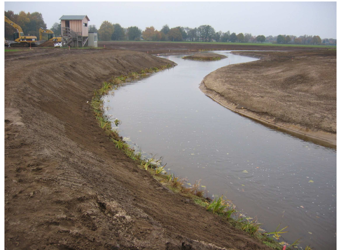
Abb. 2: Neu geschaffener Mäander der Wietze mit kleiner Stromteilung unmittelbar nach Abschluss der Arbeiten
