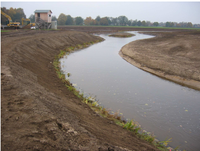
Abb. 2: Mäander der Wietze mit kleiner Stromteilung unmittelbar nach Abschluss der Arbeiten
