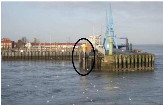
Abbildung 1: Anordnung des Meßpfahls vor dem Steubenhöft
