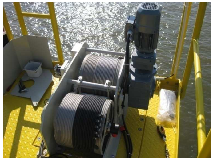
Abbildung 3: Windenanlage für das vertikale Verfahren des Schlittens
