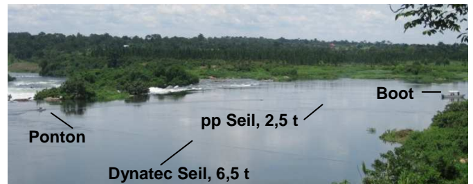
Abb. 4: Sicherung des Pontons von oberstrom
