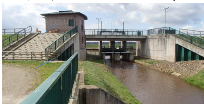
Abb. 2: Auslassbauwerk HRB Annenheide
