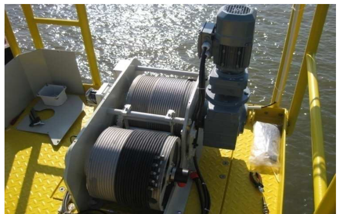
Imagen 3: Instalación de cabestrantes para el desplazamiento vertical de la corredera
