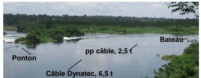
Fig. 4: Sécurisation du ponton depuis amont
