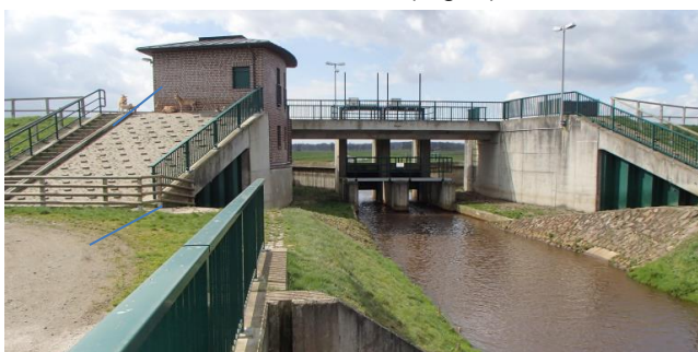
Fig. 2: Ouvrage de restitution du bassin de retenue des eaux de crue d'Annenheide
