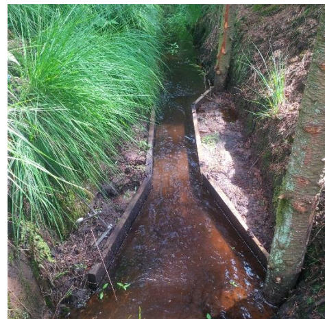
Abb.3: Abflussmessrinne in den „Krickmeeren“
